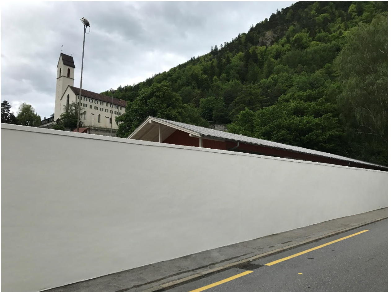
Neue Aussenmauer Badi Sand
